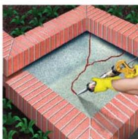
Заполнение швов и трещин в бетонных плитах перед укладкой рубероида или жидких битумных мембран.
