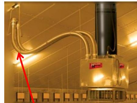
Гибкая труба для отвода продуктов сгорания и подачи свежего воздуха необходимого для сжигания.
