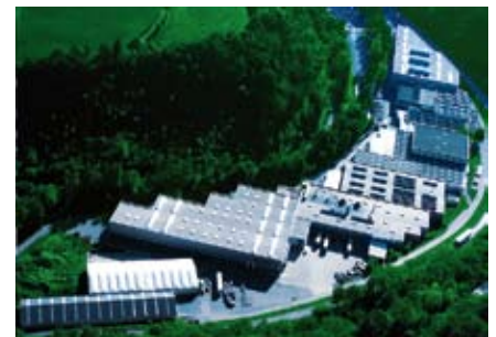
Bieringen, Produktion Axialventilatoren Bieringen, axial fan production
