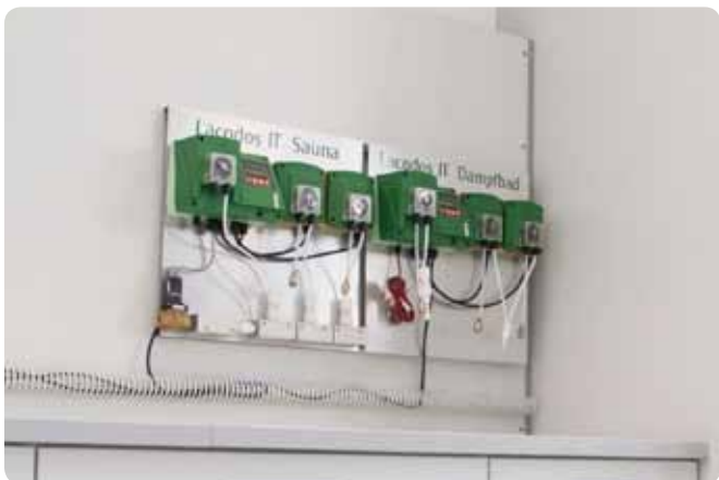
Тестовое оборудование - насосы для дозирования ароматов
