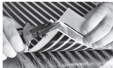
Рис. 6. Крепление контактного зажима к термопленке
