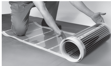
Рис. 3. Раскатывание рулона теплового пола на теплоотражающем материале
