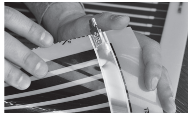
Рис. 5. Установленный на термопленку контактный зажим
