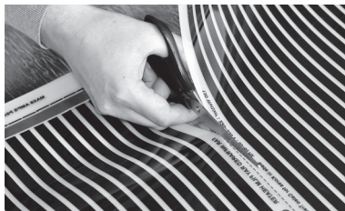
Рис. 4. Разрезание термопленки по линиям отреза
