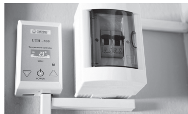
Рис. 20. Терморегулятор, подключенный к сети через отдельный автомат
