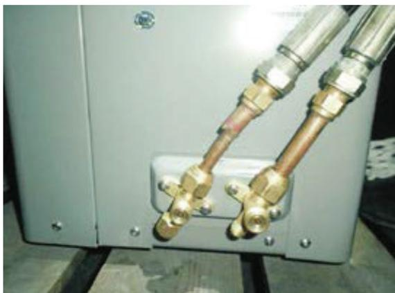
4. Когда манометр покажет отрицательное давление, выключите вакуумный насос и установите медные гайки обратно на коннектор высокого давления.
