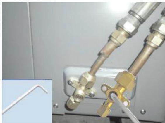
5. С помощью 5мм шестигранного ключа откройте два клапана блока (см. рисунок).
