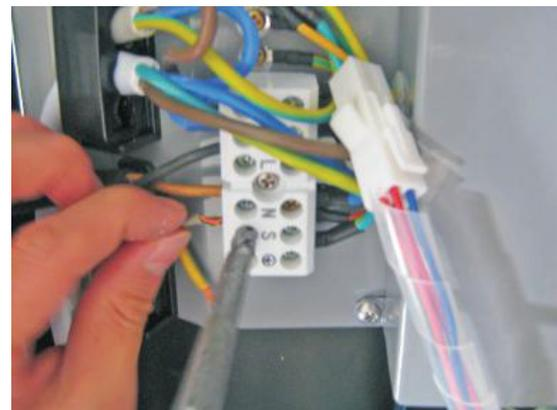
4. Подключите кабель питания к клеммному блоку согласно электросхеме внутреннего блока.
