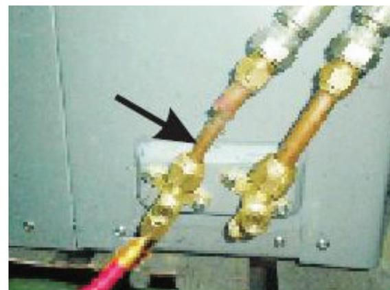
4. Снимите медные гайки коннектора высокого давления. Подключите другую сторону трубки манометра к клапану (см. рисунок). Откройте манометр и запустите вакуумный насос минимум на 15 минут.
