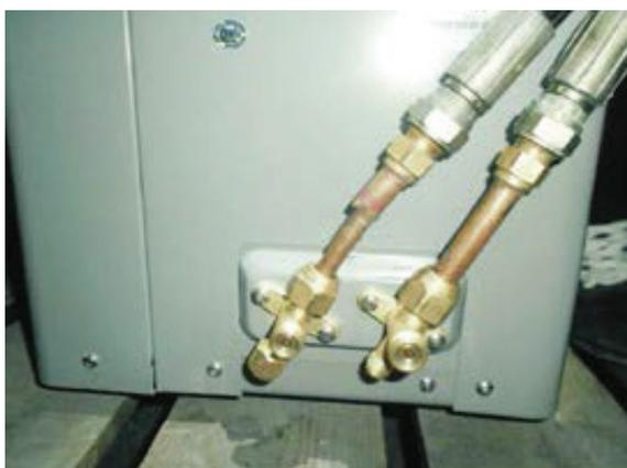
6. Установите медные гайки на место, затянув их с помощью гаечного ключа
