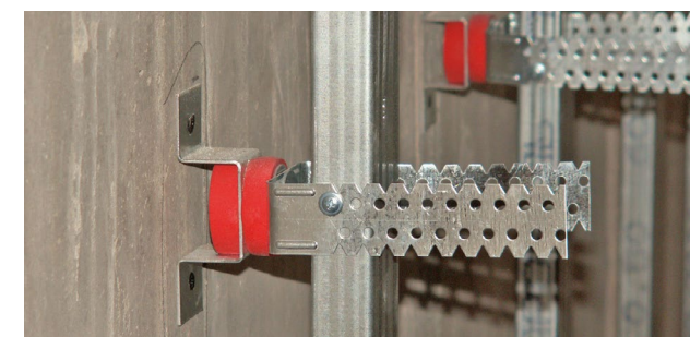
Каркас звукоизоляционной облицовки KNAUF W623, смонтированный с помощью эластичных креплений Vibrofix CD
