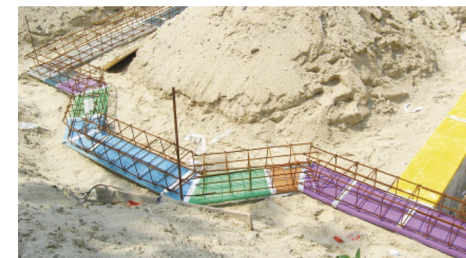
Виброизоляция фундамента жилого дома от вибраций метрополитена, Киев Виброизоляционный материал: Sylomer SR
