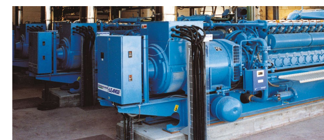
Виброизоляция генератора с помощью Vibrofix Block
