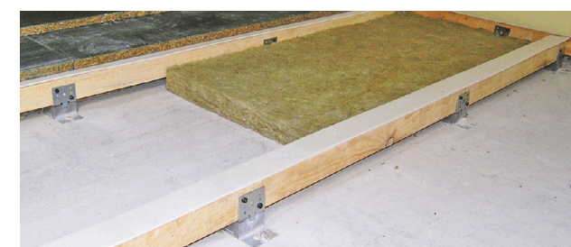
Монтаж плавающего пола на лагах с применением креплений Vibrofix Floor Plus
