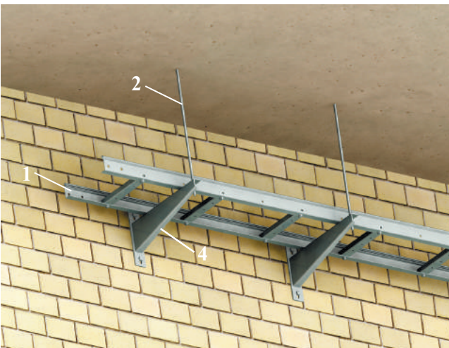
Монтаж опор к стене и потолку на консолях монолитных при помощи шпилек
