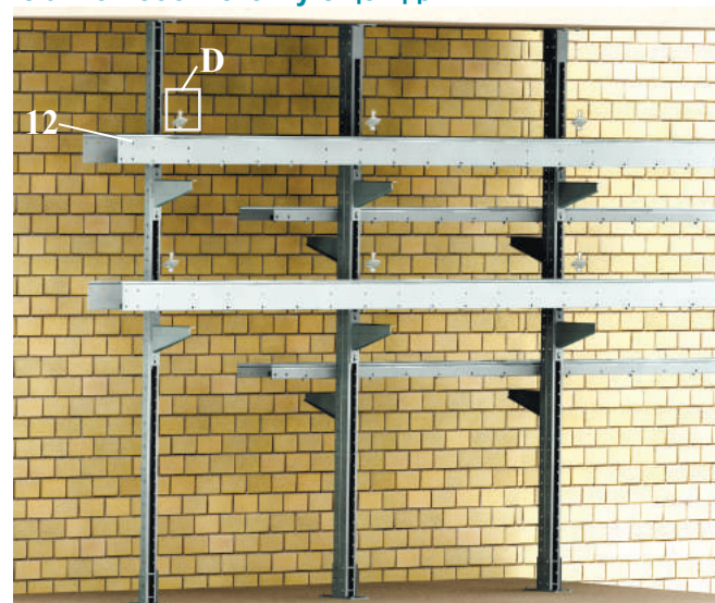
2 этап - крепление лотка лестничного к консолям
