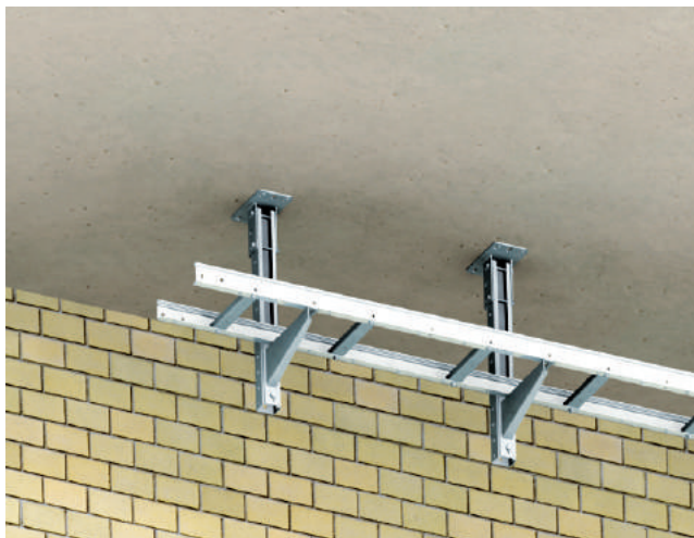
3 этап - кабельная трасса проложена и готова к прокладке кабеля
