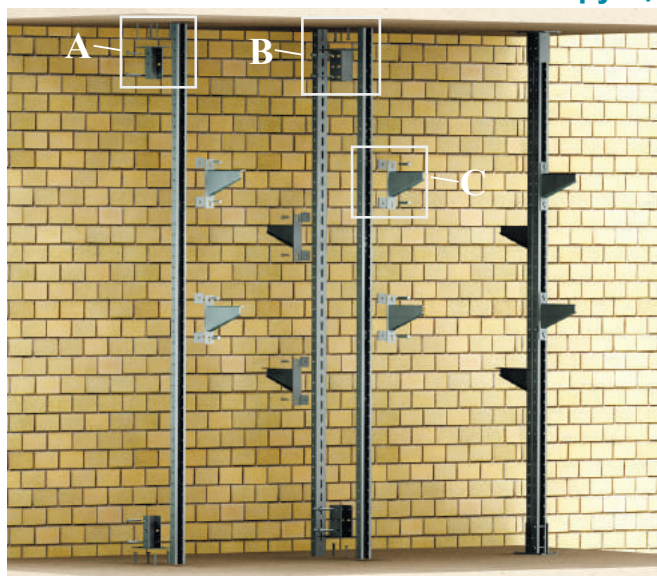
1 этап - монтаж станин к потолку и полу в распор планкой соответствующей длины
