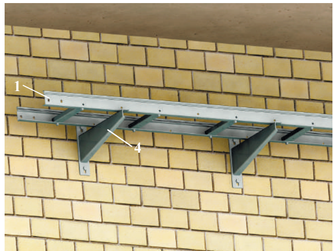
Монтаж опор к стене на консолях монолитных
