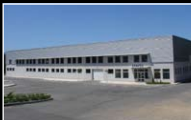
Производственный корпус в Серпинсе (UPS) - строение 2
