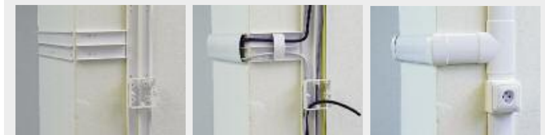
Установка кабель-каналов Элегант LE.
