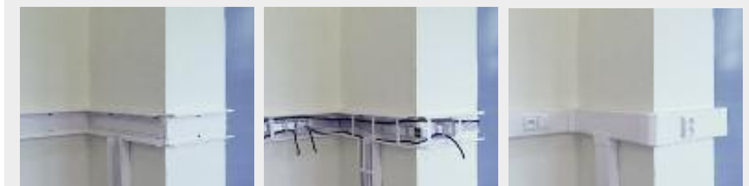
Установка кабель-каналов Элегант ЕКЕ.
