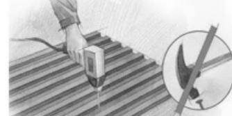
6. Отверстия для крепления должны быть просверлены. Сверло должно быть в диаметре на 3-5 мм больше диаметра шурупа. Минимальное расстояние от края плиты до монтажного отверстия – 40 мм.
