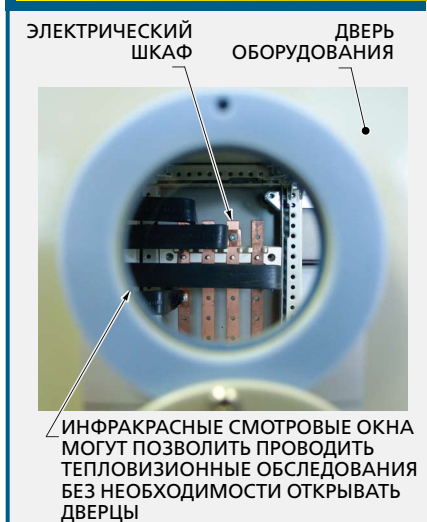
Рис. 6-2. Инфракрасные смотровые окна обеспечивают прохождение инфракрасного излучения к тепловизору без необходимости открывать дверцы или шкафы.
