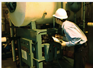
Рис. 10-1. Специалисты по эксплуатации регулярно проверяют внешний вид и звучание работающего оборудования, проводя визуальное обследование и прослушивание.
