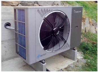
Для борьбы с шумом весь термодинамический контур изолирован акустической изоляцией, в частности, компрессор имеет свою изолирующую оболочку, и все стенки, которые содержат контру, имеют соответствующую акустическую изоляцию. Кроме того, чтобы избежать шума, вызванного вибрацией, используются резиновые прокладки. Таким образом, вибрации приглушены и шум снижается.
