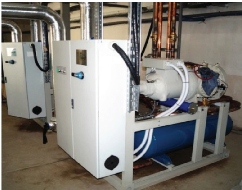
Внешний вид чиллеров (установок для охлаждения жидкости)
