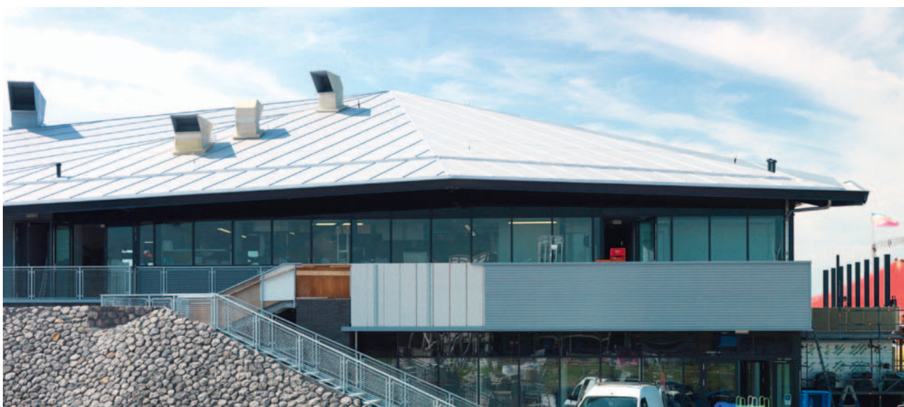
Нидерланды, г. Леммер, офисное здание, 1 200 м 2
