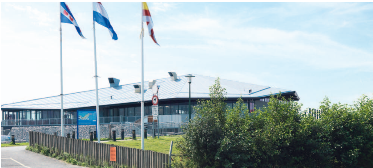
Нидерланды, г. Леммер, офисное здание, 1 200 м 2
