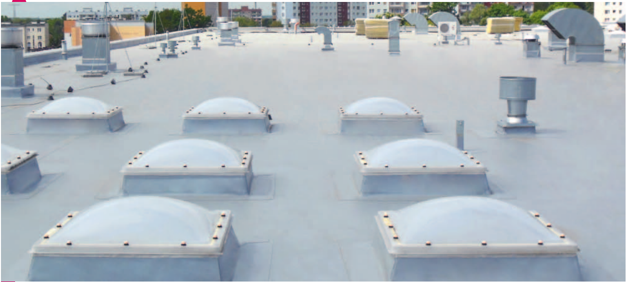
Польша, г. Эльблонг, торговый центр «Огороды», 25 000 м 2
