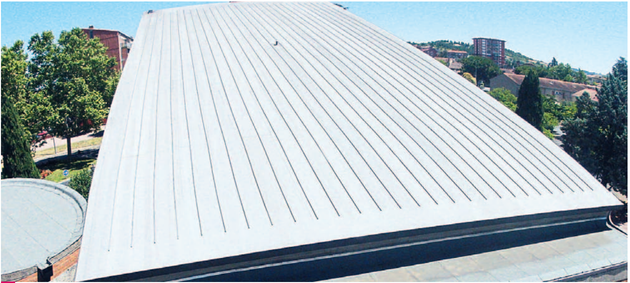
Франция , комунна Рессак, церковь, 2 500 м 2
