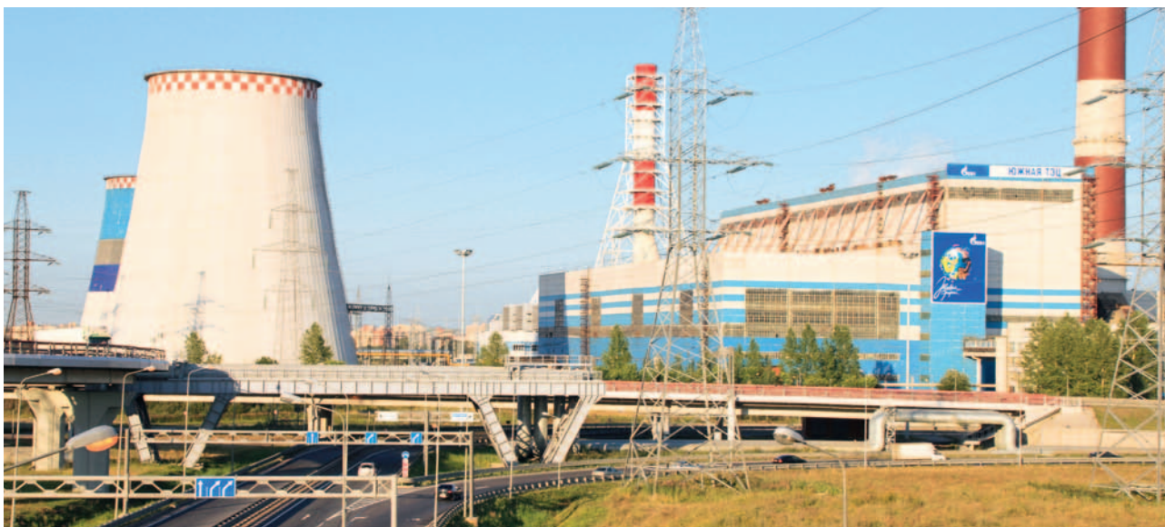
Россия, г. Москва, электростанция, 7 000 м 2
