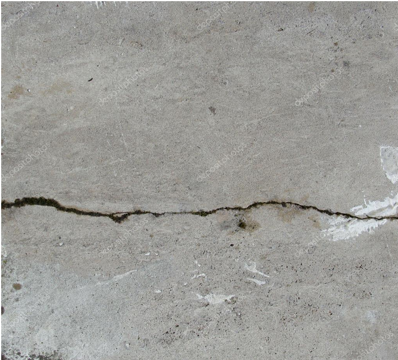
Рис.1 Типовая трещина в асфальтобетонном покрытии.
