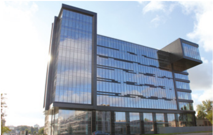
Бизнес-центр Белоостровская 6, Россия/Санкт-Петербург
