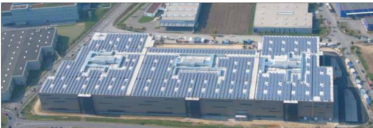
Установка 1 МВт 1 MW installation
