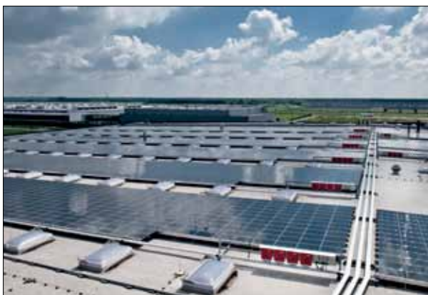
Установка 1 МВт 1 MW installation
