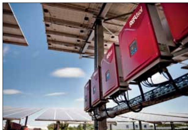
Установка 4,6 МВт 4.6 MW installation
