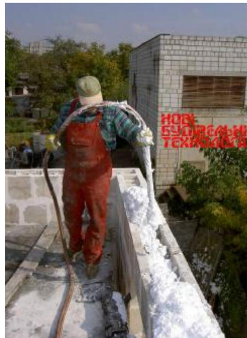
затраты на отопление снижаются в несколько раз, а стоимость всех работ по утеплению покрываются менее, чем за один отопительный сезон. Если заполнить карбамидным пенопластом внутренние проемы стен или утеплить им дом снаружи, то даже в сильные морозы понадобится лишь кратковременно отапливать помещения, а затем при выключенном источнике тепла температура не будет понижаться в течение 8-10 часов.
