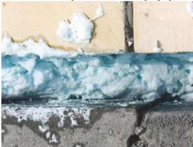
переходе в твердое состояние (лед) может нарушить механическую структуру пенопласта. Поэтому все же **пеноизол** должен находиться в среднем слое конструкции и если произошло разрушение внешней стены, то ее следует до холодов заделать.
