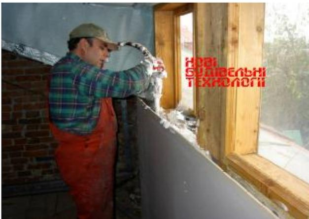
В конструкциях, заполненных **пеноизолом (юнипором)**, даже при наличии трещин во внешней стене опасность проникновения влаги в помещение исключается. Даже при большом скоплении влаги на границе раздела внутренней **ПОВЕРХНОСТИ** внешней стены и утеплителя, несмотря на свою открытопористую структуру,
