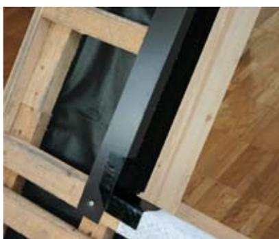
Во время монтажа окна очень важно герметично соединить окно с подкровельной гидроизоляцией. Roto разработало специальный монтажный комплект, который гарантирует надежное и плотное соединение окна с кровельной мембраной. В состав комплекта
